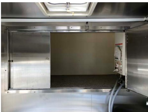
収納棚、電気給湯器
